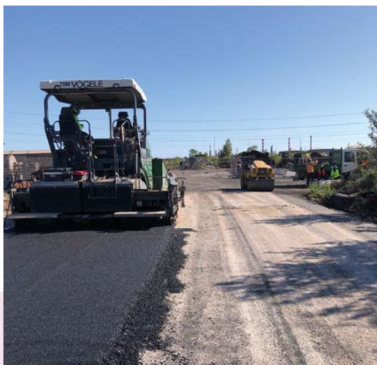
Nouvelle voie d'accès aménagée avec le laitier d'aciérie
